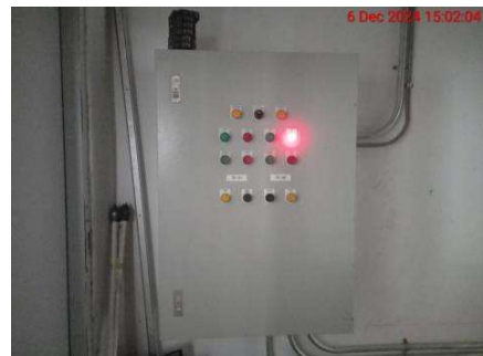
แผงควบคุมระบบบำบัด
