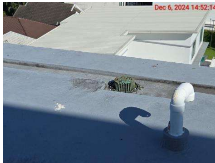
หัวรับน้ำฝน (Rain Drain)
